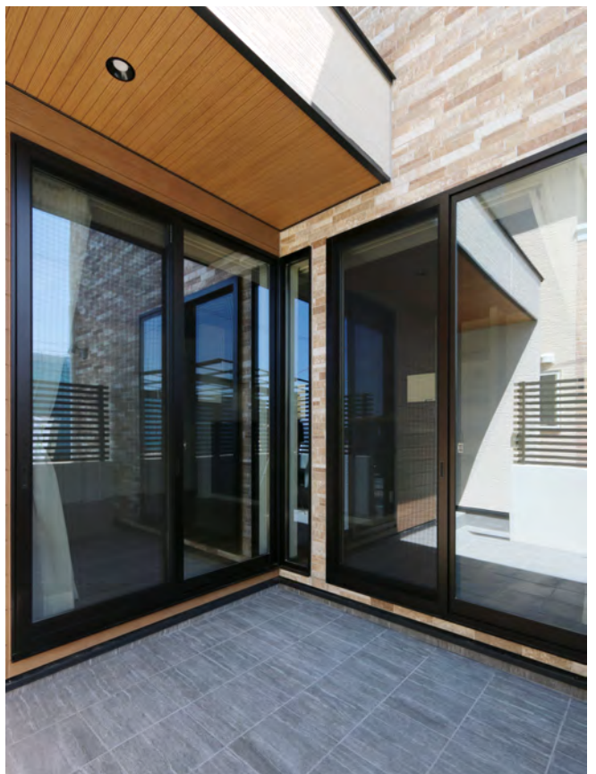
リビングとダイニングからアクセスできる中庭空間はタイルテラス。しっかりと出した軒出がリビングに入る夏の暑い太陽光の量を調整してくれる。
