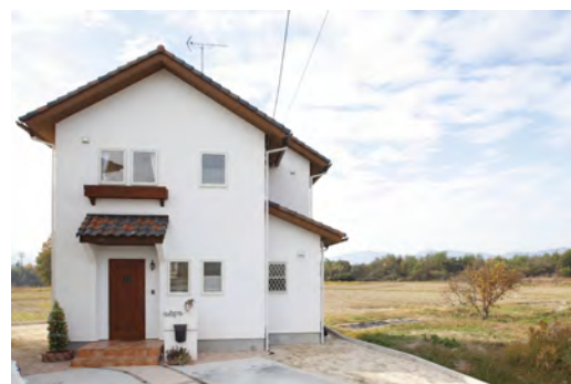
刈り入れの終わった田園にじっくり溶け込むE邸。素焼きの瓦や塗り壁が自然と呼応して美しい。
